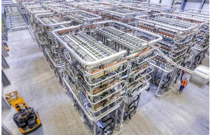
**Schaltzentrale:** Konverter wandeln Wechsel- in Gleichstrom um und ermöglichen so den verlustarmen Stromtransport über große Strecken.
