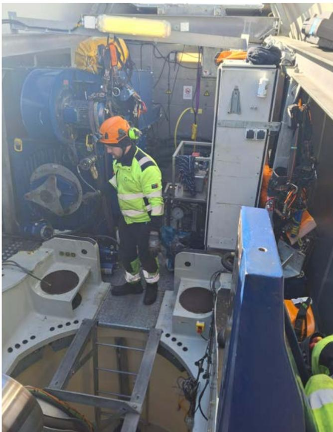
**Maßgerecht:** Das alte Getriebe ist bereits ausgebaut, das neue wird nahtlos seinen Platz einnehmen.
